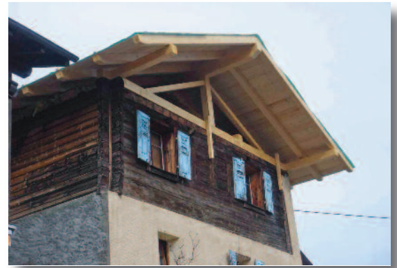
Photo d'une rénovation à Buitonnaz
