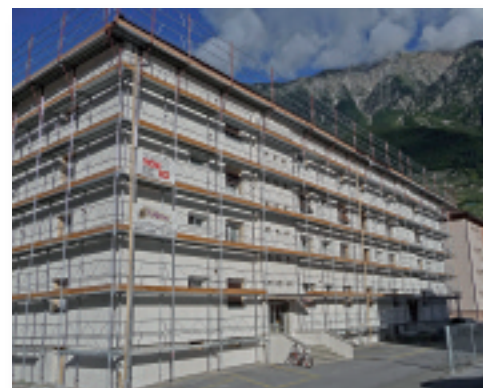
Une rénovation complète commence souvent par les fenêtres
