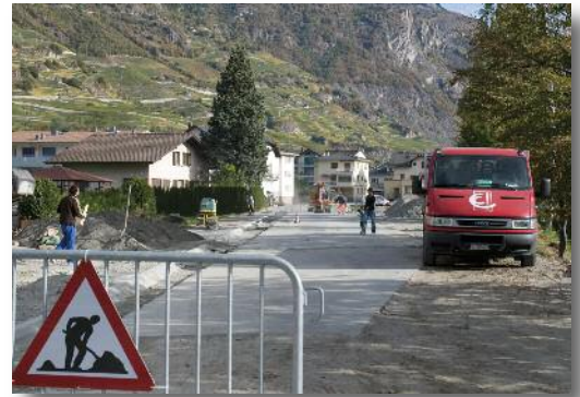
Chantier de la rue du Stade
