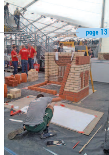
Un maçon à l'œuvre
