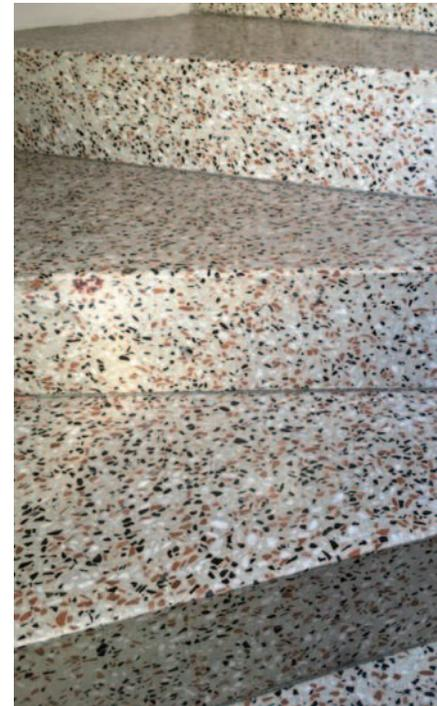
avec la truelle pour bien façonner, puis, en raclant contre soi. A la fin, on rajoutait du simili brut mais sec et on tassait à fond avec une dame de maçon, ainsi cela devenait vraiment très costaud ! Après deux jours, afin de dégager le moule avec un ciseau plat de maçon, on tapotait entre le moule et la pièce et cela se décollait assez facilement.
